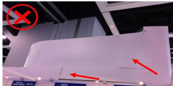
如使用白板封妥，需平滑地及牢固地安装。
