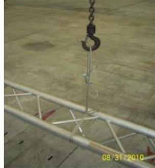
5. 悬挂钢木结构内部必须有整体可靠连接的金属框架, 并有开口可以看清内部结构, 如发现纯木结构、或者使用没有相互连接或连接不可靠的金属部件, 不得做吊点悬挂。单片金属框架外封木板的悬挂结构, 必须通过上部有整体框架组合的桁架来悬挂;
